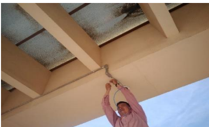
CASETA (ENTRADA PRINCIPAL)
